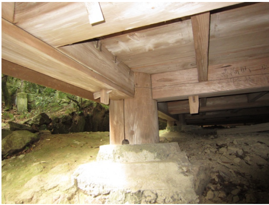
写真2 礎石建ち構法の一例
